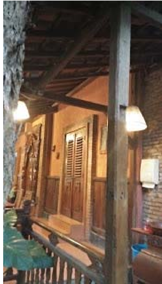
Gambar 5. Pintu yang masih asli Sumber: dokumentasi pribadi. 2018
