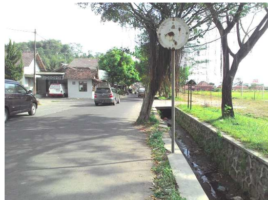
Gambar 2. Kondisi salah satu kondisi penunjuk arah yang rusak, tidak terlihat, terawat dan terbaca ( wayfinding ) di Desa Gunung Pring Muntilan (Sumber: Dokumen Penulis, 2015).
