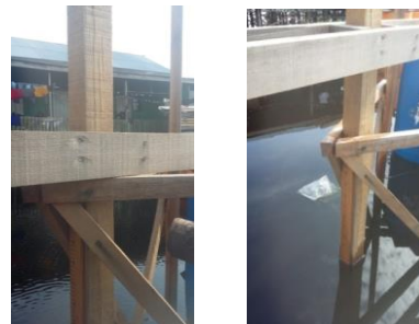
Gambar 6. Konstruksi apung belum mengapung (kiri) dan konstruksi apung telah mengapung ketika ketinggian air 141 cm (kanan).
