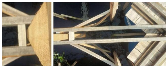
Gambar 7. Hubungan balok pengikat kestabilan Tiang utama konstruksi apung dan Konstruksi Tiang Penggerak Vertikal.
