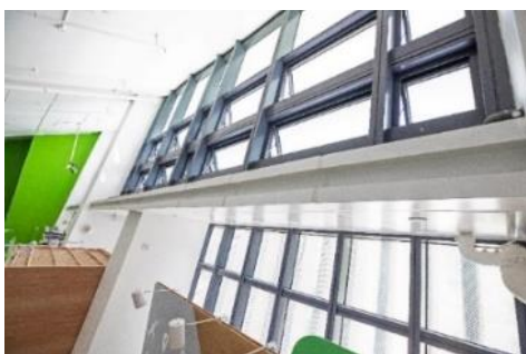
Gambar 18: Bukaan dari barat laut dan tenggara (Sumber: CIC-ZCP (Construction Industry Council & Zero Carbon Park, 2022)
