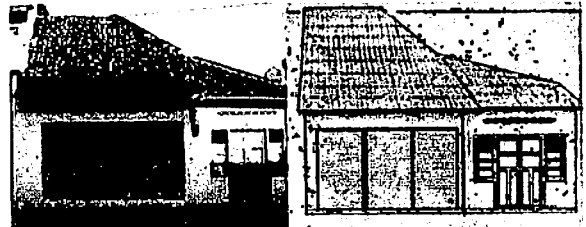
Gambar 4. Bangunan kuno dengan gaya bangunan tahun 1930-an (Sumber: Aryati, 2012).
