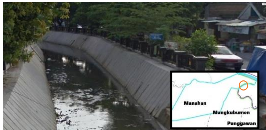
Gambar 4.3 Kondisi Eksisting Sungai Pepe di Kelurahan Sumber
