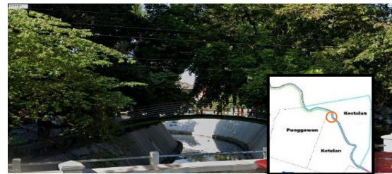
Gambar 4.9 Kondisi Eksisting Sungai Pepe di Kelurahan Kestalan
