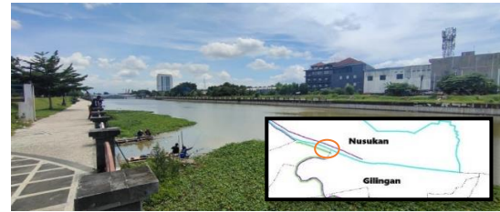
Gambar 4.4 Kondisi Eksisting Sungai Pepe di Kelurahan Nusukan
