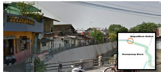
Gambar 4.13 Kondisi Eksisting Sungai Pepe di Kelurahan Kampungbaru
