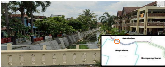
Gambar 4.11 Kondisi Eksisting Sungai Pepe di Kelurahan Keprabon
