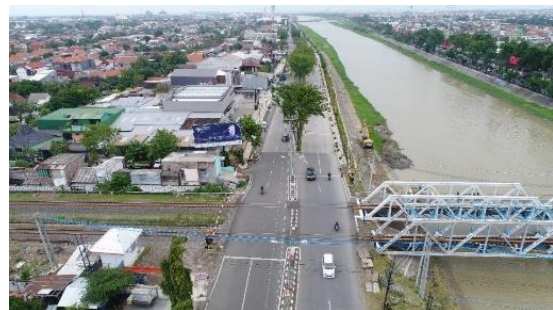
Gambar 3.2 Lokasi Perlintasan Sebidang Jalan Madukoro Raya Sumber : Hasil Survey 2018
